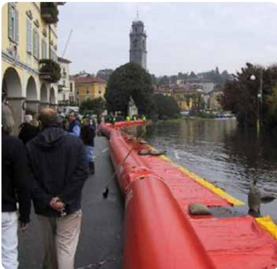
**Fig. 2** - Posa della barriera anti inondazione durante la piena sul lago Maggiore a Verbania 2004 (NOAQ Flood Protection AB, distribuito dal Falzoni s.a.s. - [www.falzoni.it](http://www.falzoni.it))
