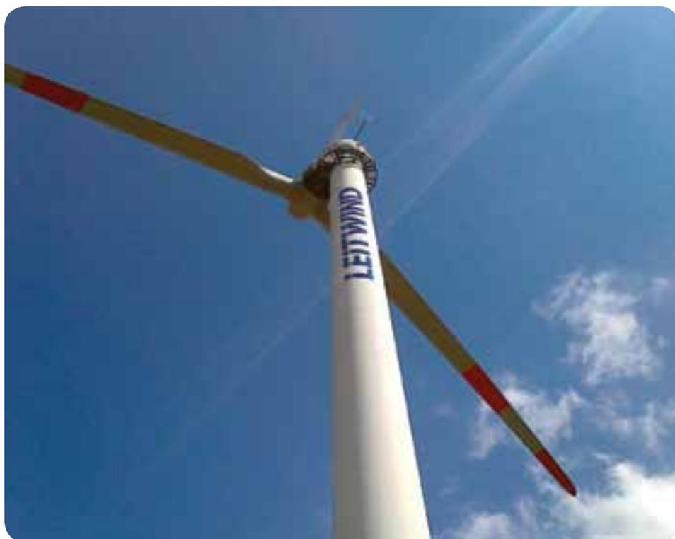
I due impianti eolici sono situati nel territorio comunale di Malles Venosta e sono stati realizzati da un consorzio di Comuni locali. Si tratta di due impianti sperimentali con aerogeneratori tripala e rotor di 62 e 68 m di diametro. La produzione complessiva è di circa 4 milioni di kWh/anno. La visita è stata accompagnata dalla presentazione degli impianti tenuti da un tecnico specializzato della Leitwind, l'azienda che ha installato le pale e che le gestisce attualmente.
