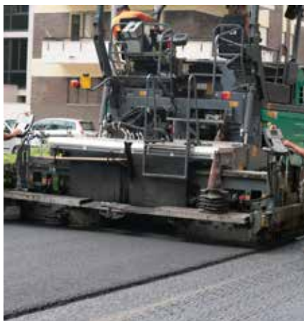
Immagine 7 - Pavimentazione in Asphalt Rubber durante la stesa ▲
