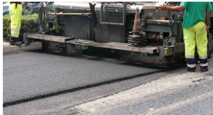
Immagine 10 - Fase di stesa di un microtappeto a caldo
