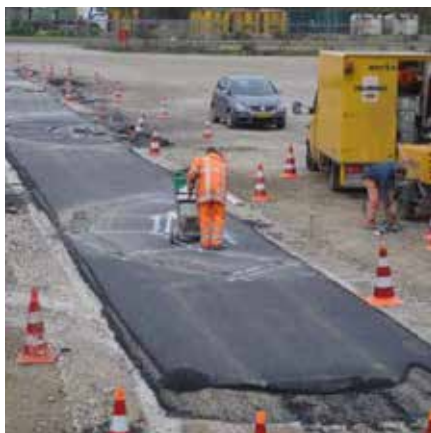
Immagine 8 - Sito di prova per pavimentazione in conglomerato drenante doppio strato
