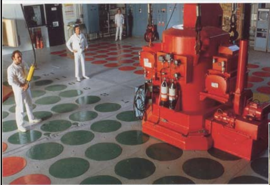
Hall de stockage de l'Atelier de Vérification de Marcoule (AVM)
