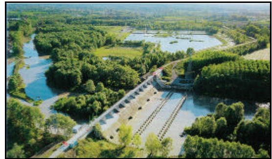
Interventi per la riduzione del rischio idraulico: la cassa di espansione sul F. Panaro (Provincia di Modena, MagisPo).
