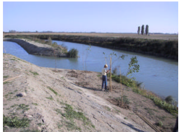
Creazione di ampie aree golenali per il ripristino della vegetazione spondale in un intervento di riqualificazione fluviale
