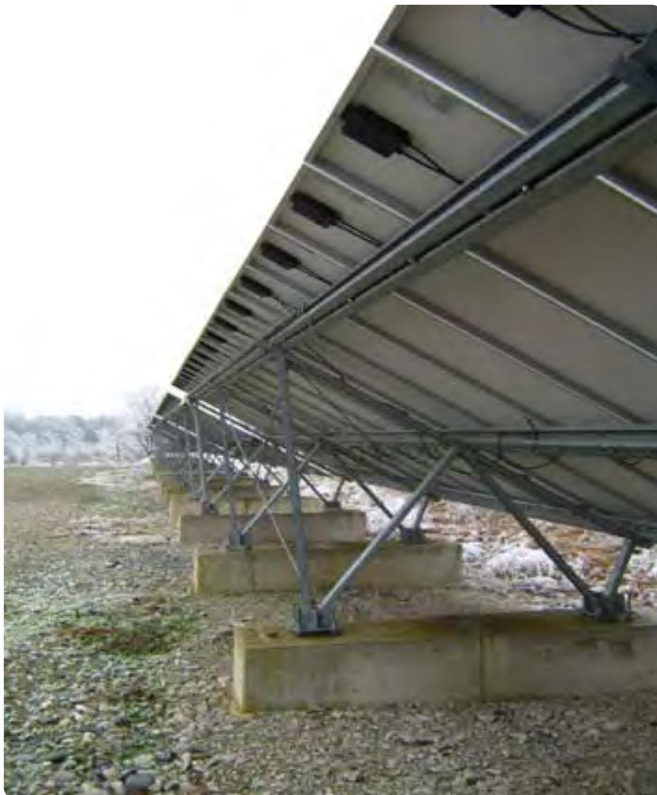
I plinti in cemento armato, di volume pari a 0,6 mc cad., sono semplicemente appoggiati sul terreno ed hanno funzione di ancoraggio tramite il solo zavorramento a causa dei possibili movimenti residuali di assestamento del terreno della ex-discarica.
