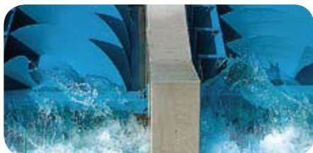
Figura 5: Coclee di un impianto ad acqua fluente
