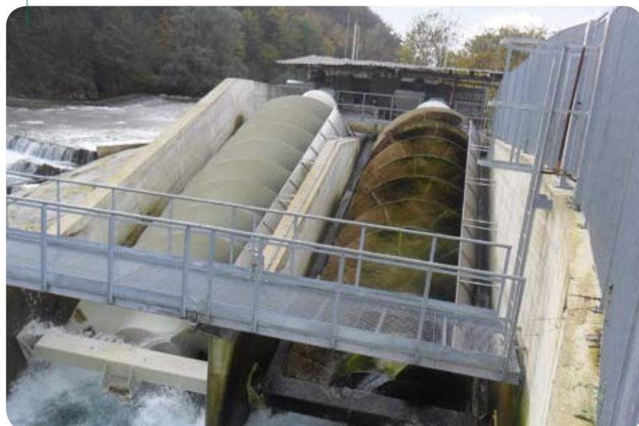
Figura 2: Coclee di un impianto ad acqua fluente a Gravellona Toce
