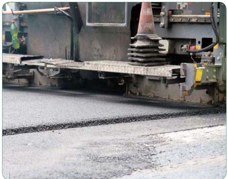
Fase della stesa di asfalto modificato con gomma da PFU.
