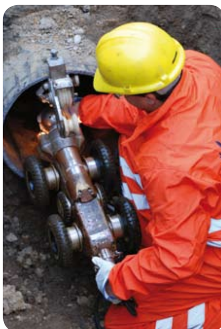
Figura 1: inserimento strumento di video ispezione fonte Foto di Carlo Torre Iren Acqua Gas SpA www.sasterpipe.it
