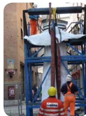
Figura 2: inserimento inliner con inversione ad acqua fonte Foto di Carlo Torre
