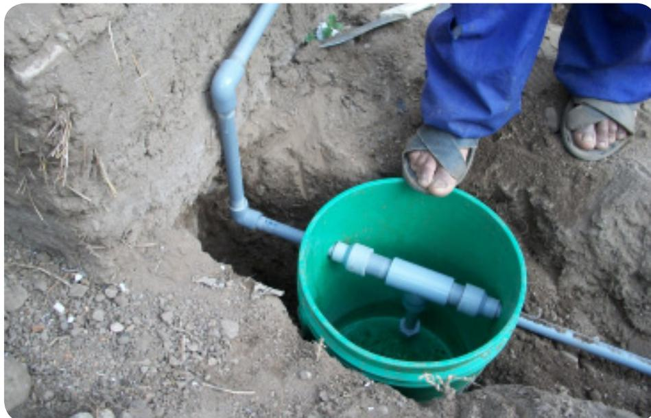
Il gas prodotto viene parzialmente raccolto all'interno della cupola sommitale del digestore tubulare, che occupa il 25% circa dell'intero volume. La parte eccedente viene convogliata mediante un sistema di tubazioni in PVC, del diametro di circa 2 pollici, verso un gasometro in geomembrana.
