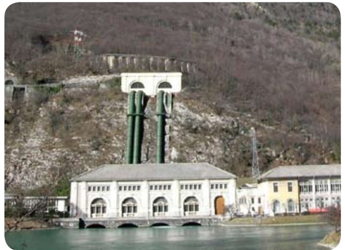
Centrale, vasca e condotte
